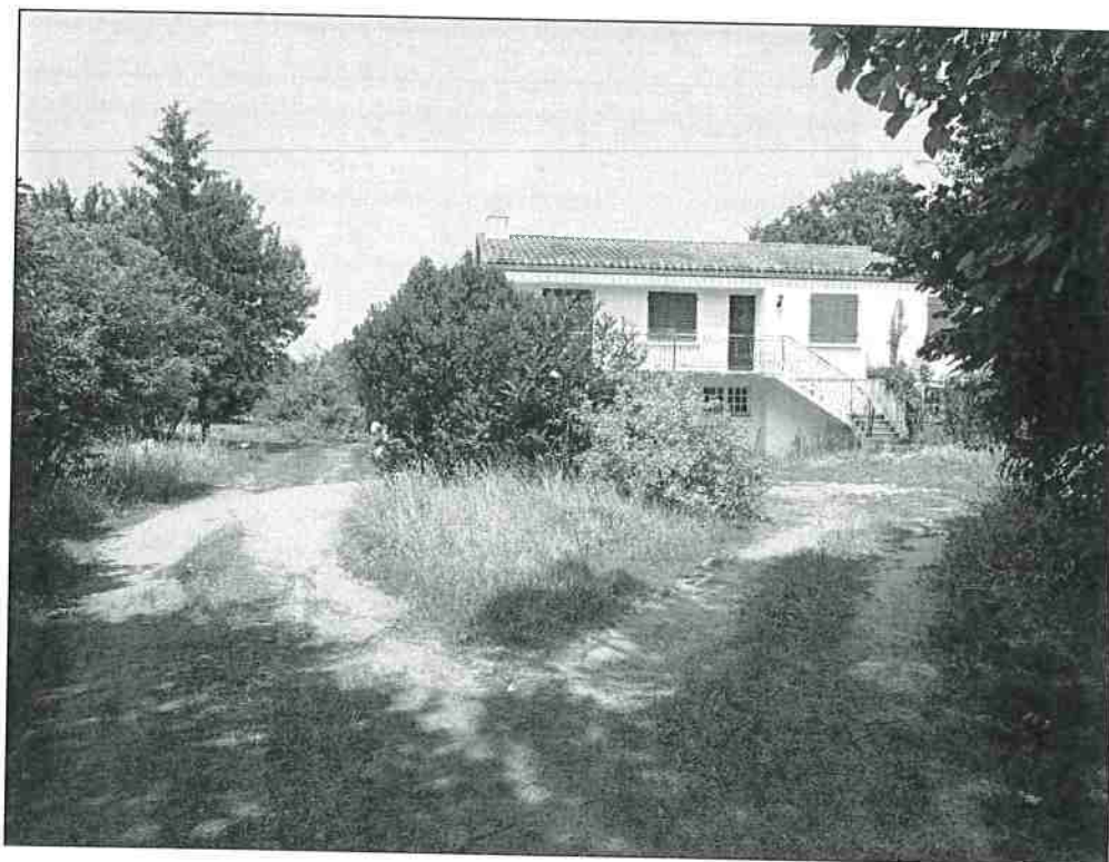
Construction existante sur le terrain
