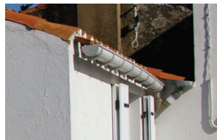
Un schéma à proscrire : la gouttière pendante en doublon avec le système traditionnel
