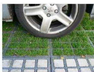
Dalle alvéolaire (béton ou plastique) - Source : Sol-aire
