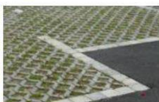
Dalle alvéolaire (béton) - Source : Even Conseil
