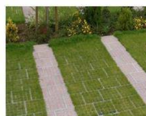
Solution mixte dalles alvéolaire/pavés Source : Sol-aire
